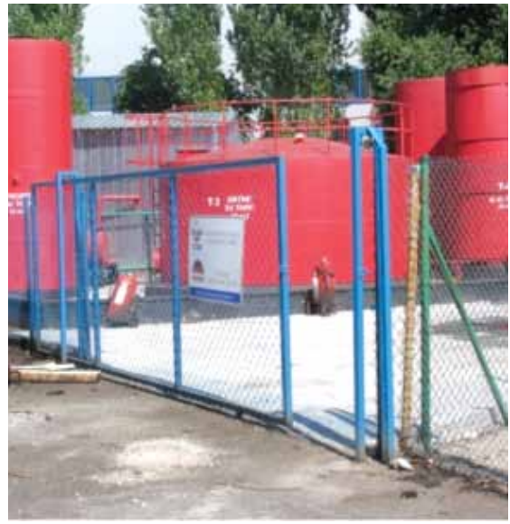
Atık Kabul Tesisi
