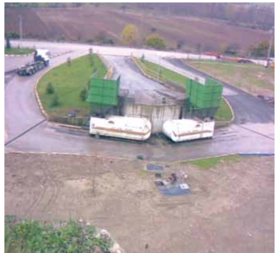
Kandıra Katı Atık Aktarma İstasyonu
