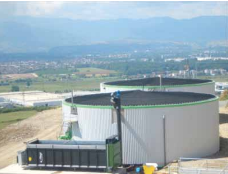
Pilot Tesis Fermanter ve Besleme Ünitesi
