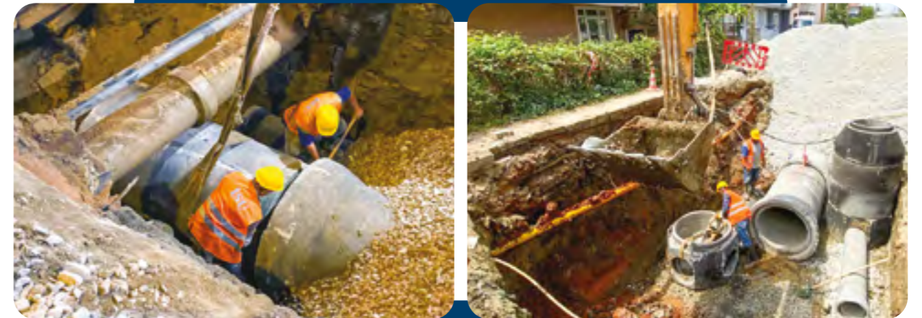
Kartepe Kanalizasyon ve Yağmursuyu İnşaatı
